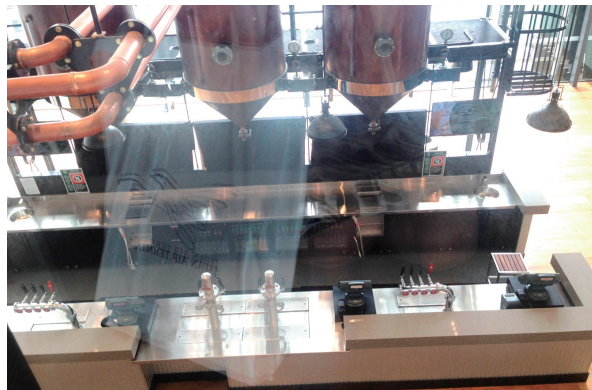
ホスピタリティ専用棟のガラス張りキッチン Sydney Cricket & Sports Ground (豪州)
